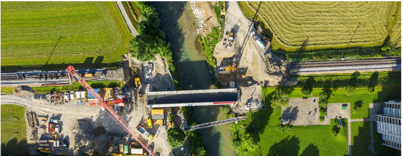
Verschub Thurbrücke im Juli 2019 (Bild SOB)
